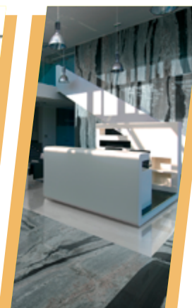
Облицовка широко- форматными плитками
