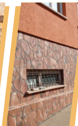
Облицовка цоколя здания
